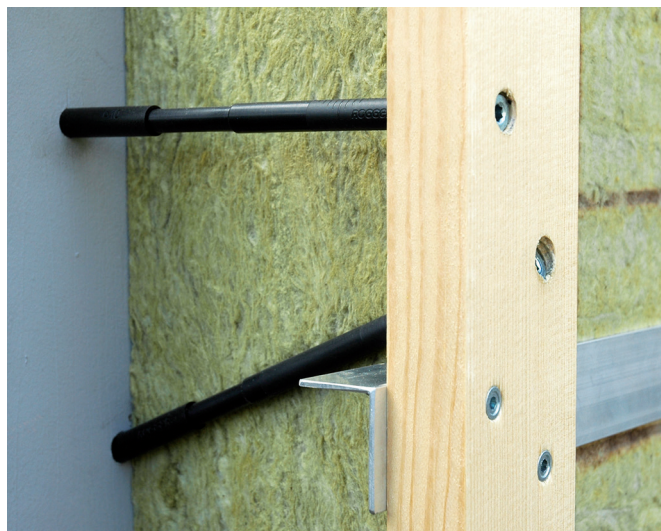
Fig. 2: Système avec vis d'écartement (Rogger)
